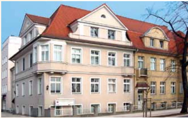
Das Gebäude des Johanniter Competence Centers in Stendal
